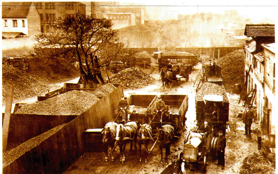
Um 1930: Das Firmengelände von ENGELKE am Britzer Damm.
